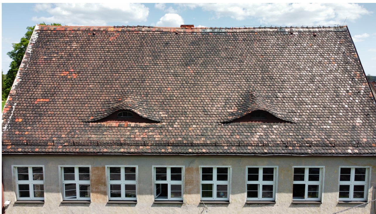
Fot. nr 11 - Lukarna dachowa typu „wole oko”
