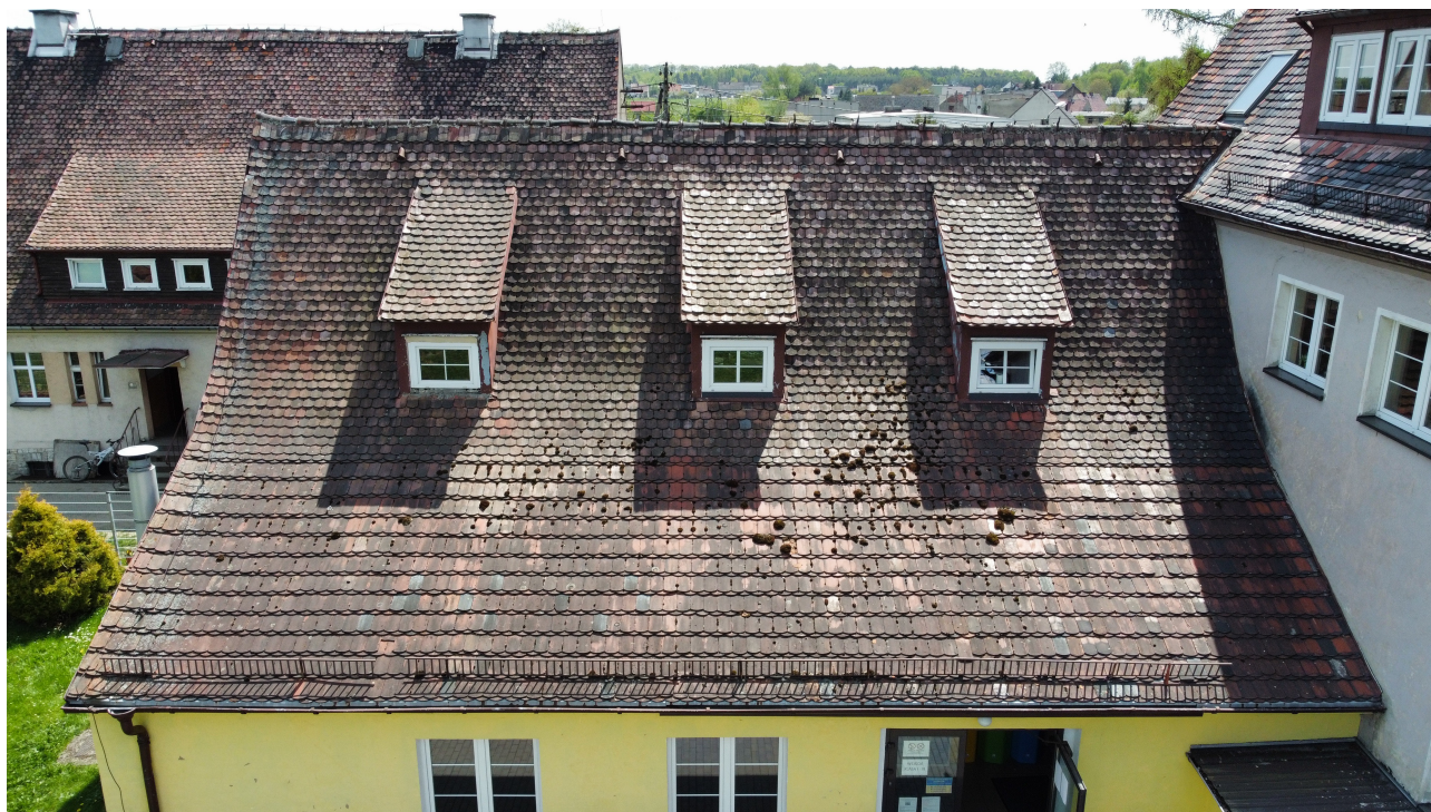
Fot. nr 10 - Lukarna dachowa jednospadowa
